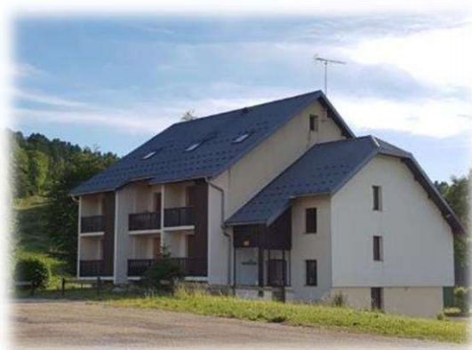
Figure 111 Immeuble au Plans d'Hotonnes
