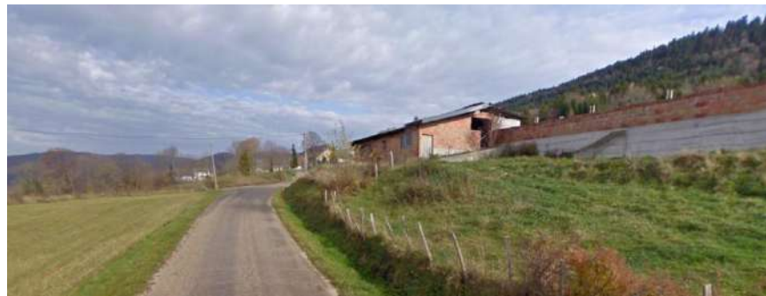
Entrée Sud RD30
