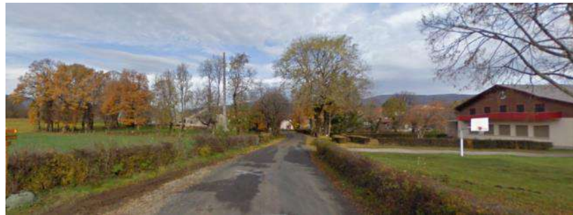
Figure 135. Entrée Sud RD9A
