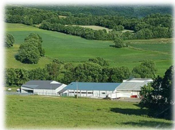
Figure 118 Bâtiment industriel (abattoir)
