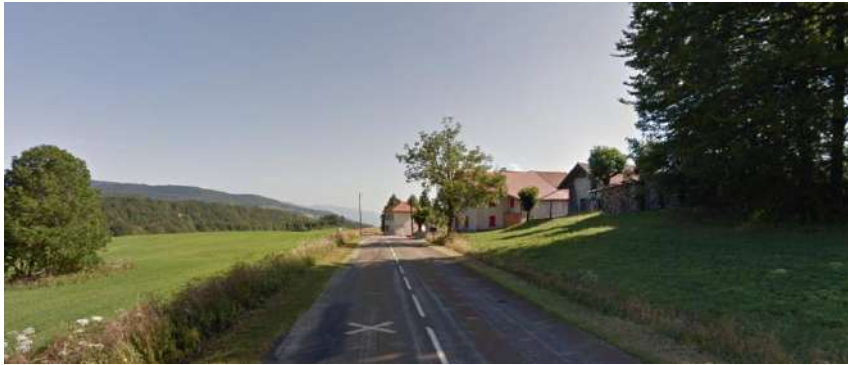
Entrée Nord RD31
