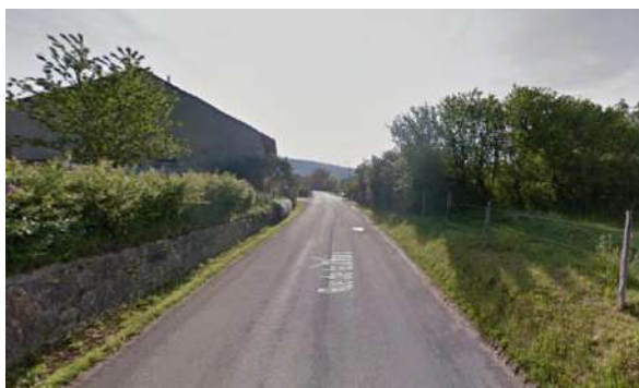
Entrée Ouest RD9
