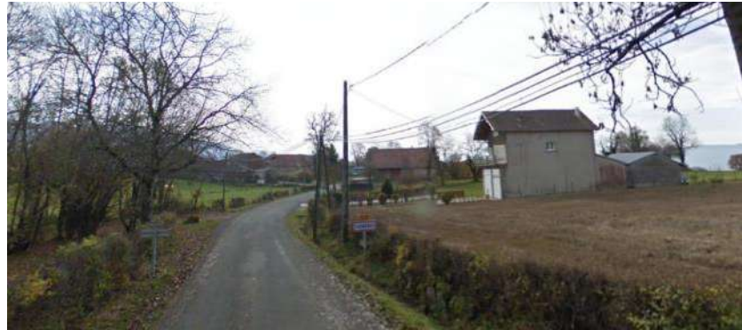
Figure 134. Entrée Nord RD9A
