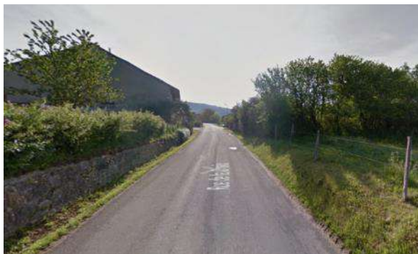
Figure 130. Entrée Ouest RD9
