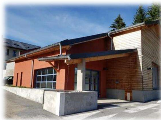
Figure 47 Salle du cercle à Hotonnes
