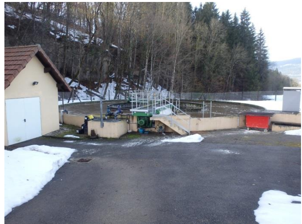
Bassin d'aération + clarificateur
