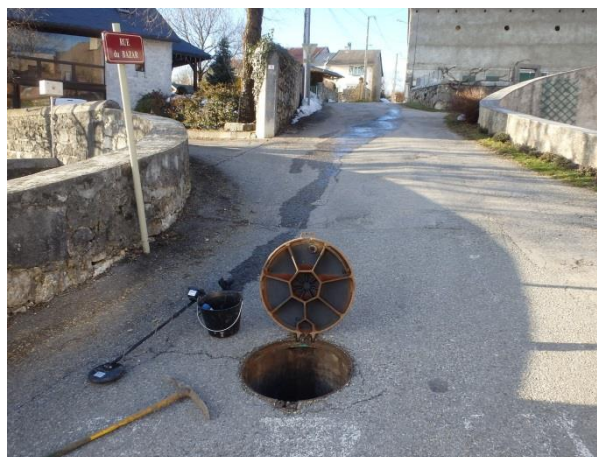
DO3 : Vue extérieure
