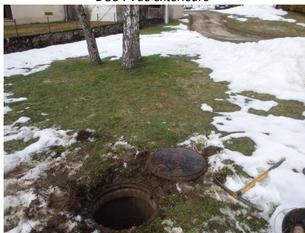
DO4 : Vue extérieure
