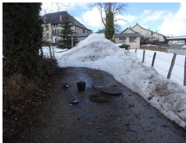
DO1 : Vue extérieure
