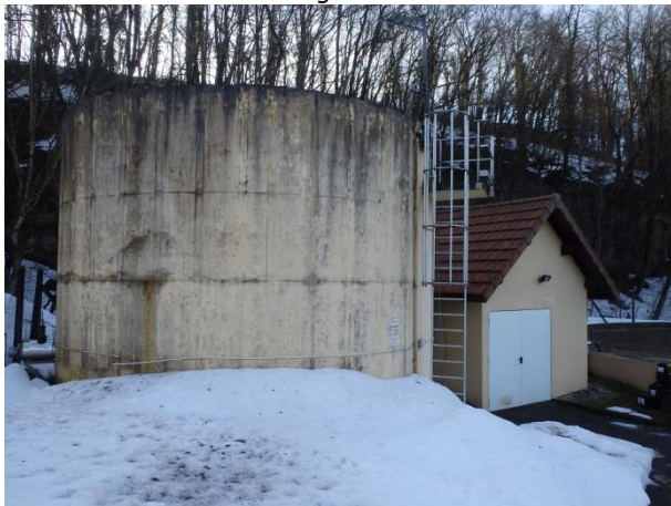
Silo à boues
