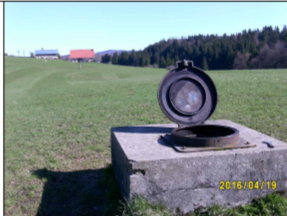
Accès à la chambre de répartition
