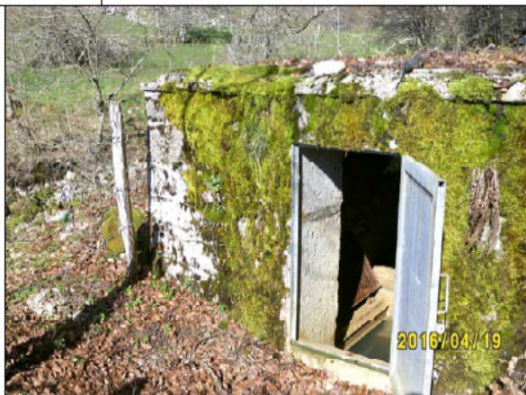
Accès à la chambre de mise en charge
