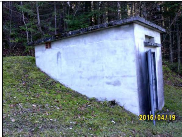
Accès au réservoir
