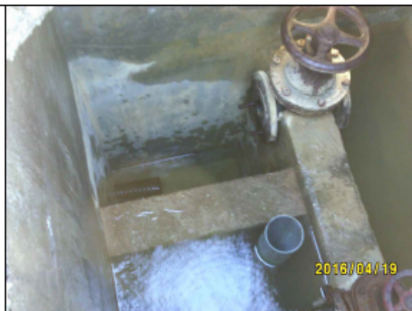
Départ vers réservoir de Jalinard Alimentation par surverse
