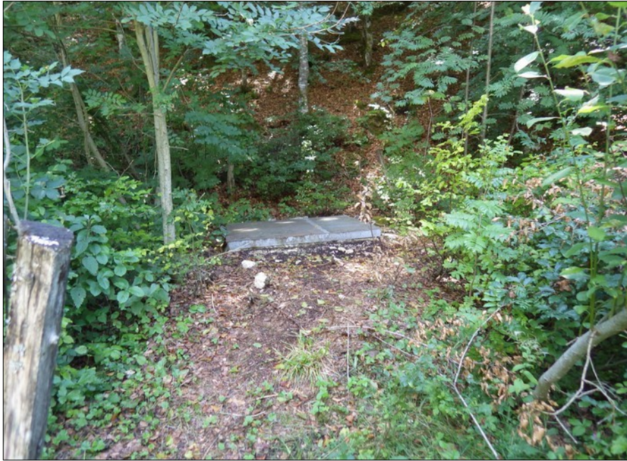
Photo 9: Capot du puits d'accès de l'ouvrage amont
