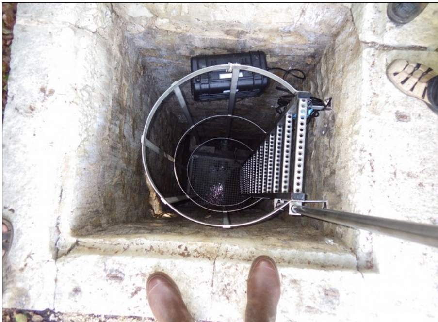
Photo 10: Puits d'accès de l'ouvrage amont
