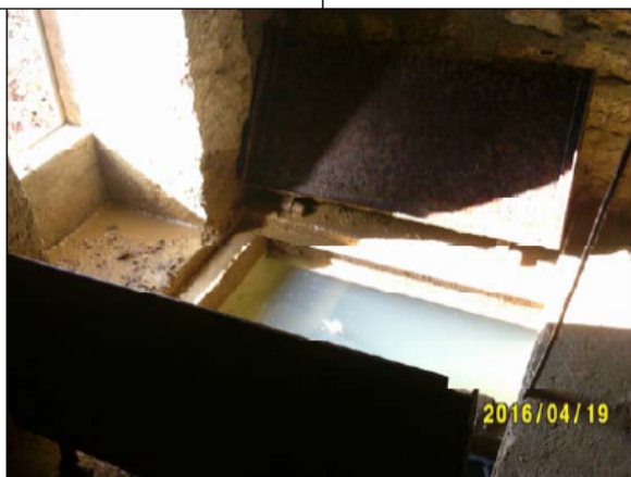
Départ vers la station de traitement
