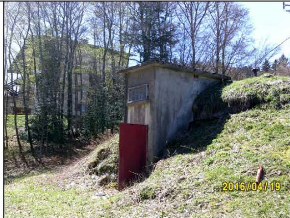
Accès au réservoir
