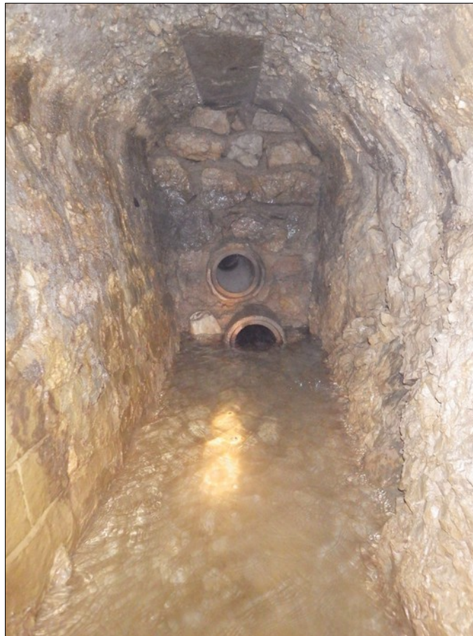
Photo 13: Extrémité aval du boyau d'évacuation
