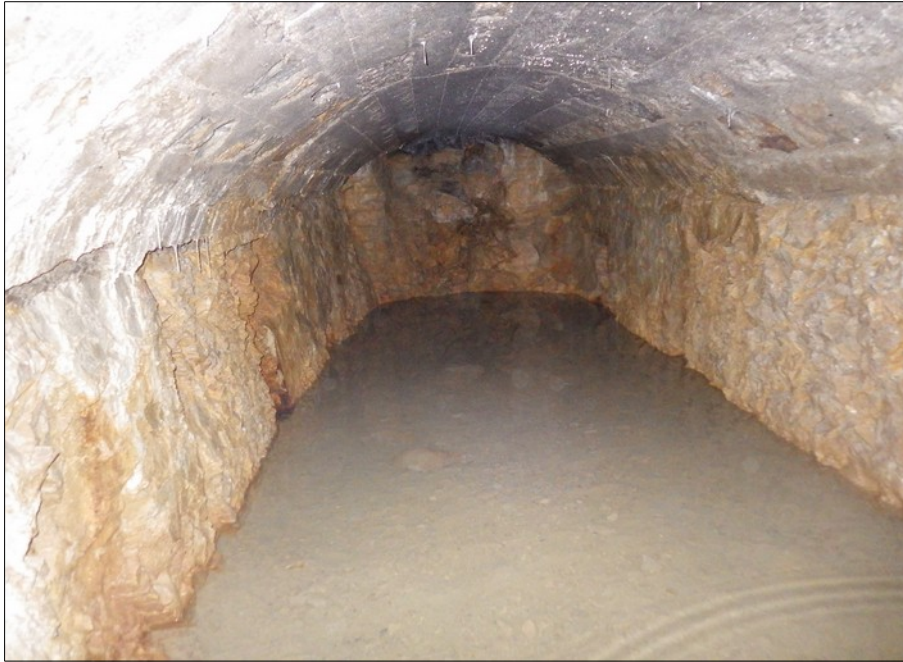
Photo 11: Chambre de captage (appelée "Galerie" ou "Voûte")
