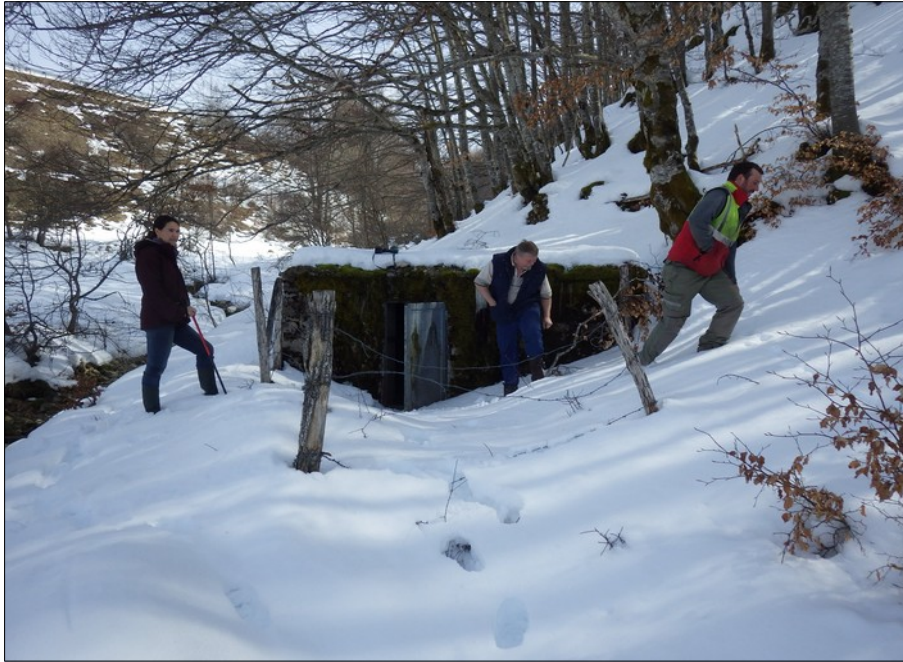
Photo 14: Ouvrage aval. Vue extérieure
