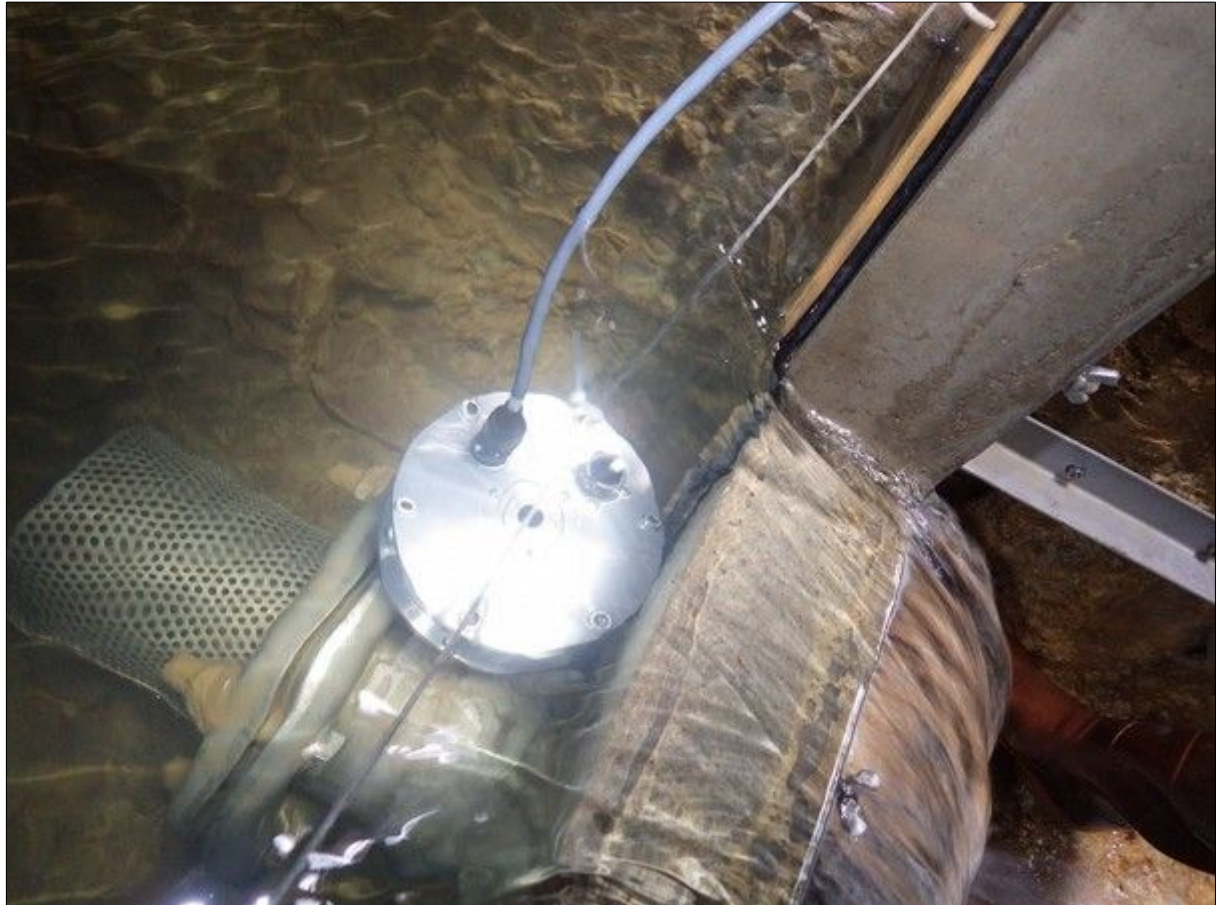
Fluorimètre Source des Vuires – « Faille »
